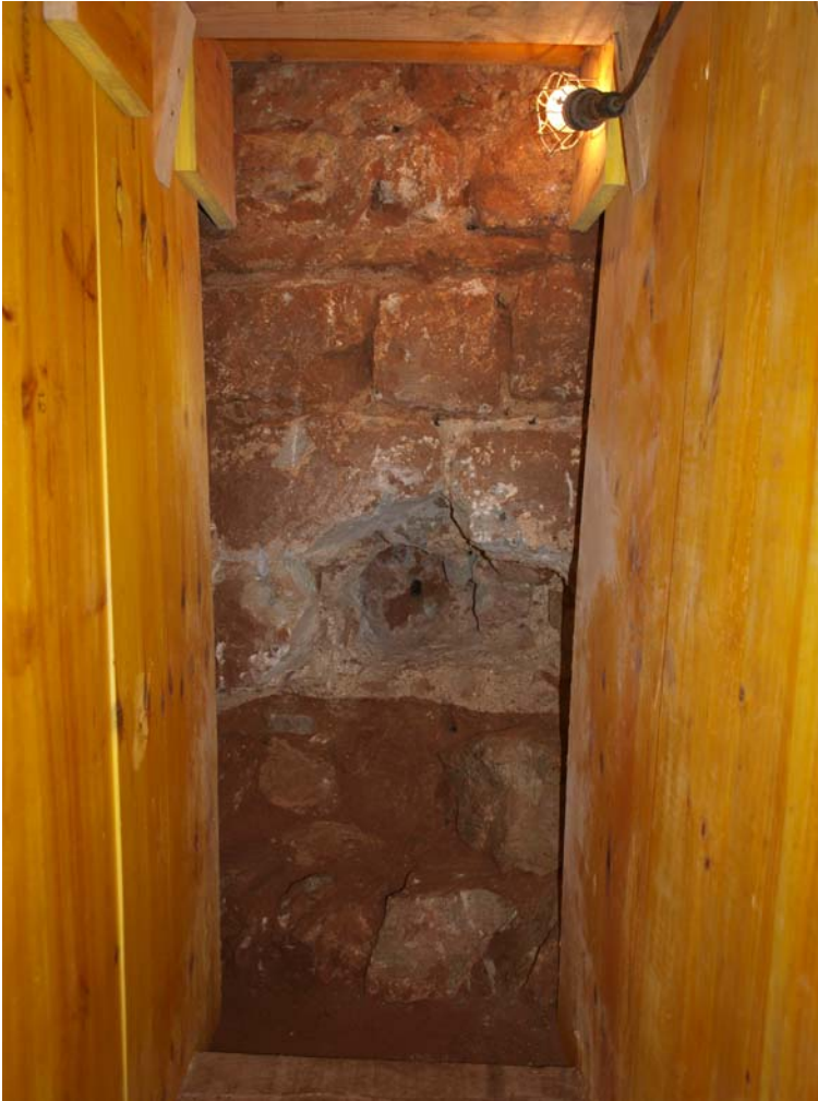
Foto 004: Vista general del mur UE 101
