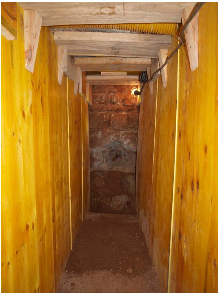
Foto 003: Vista general de la mina i del mur UE 101
