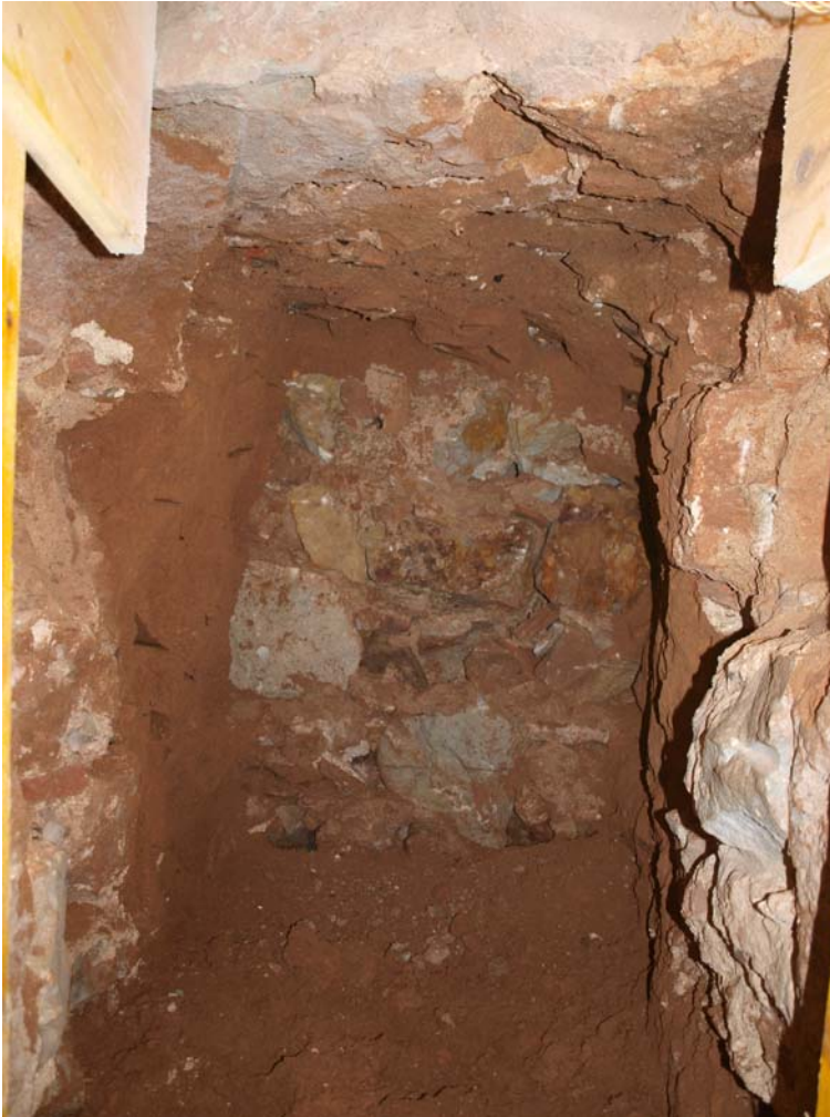
Foto 008: Mur UE 105 del col·lector
