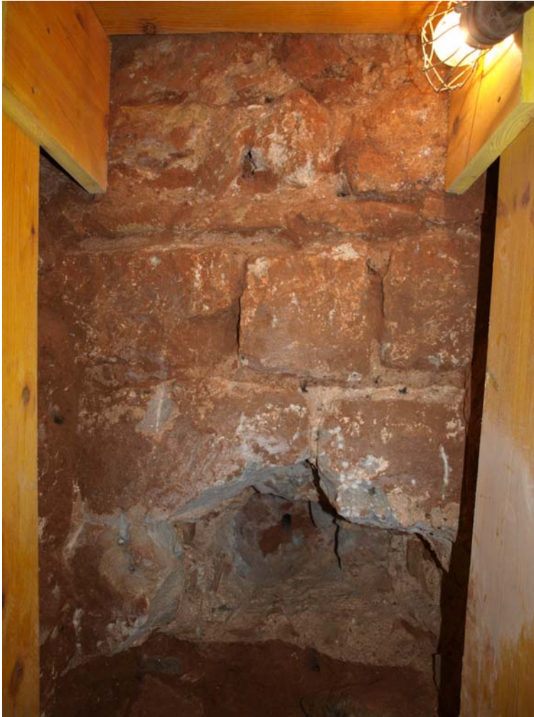
Foto 5: Part superior del parament del mur UE 101
